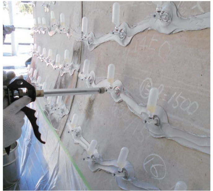
土木構造物 改修 トンネル内壁
