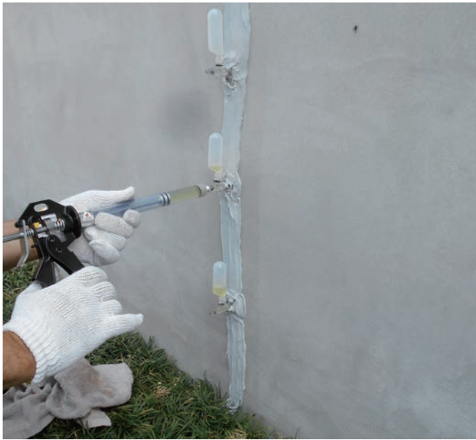
建築構造物 新設 腰壁
